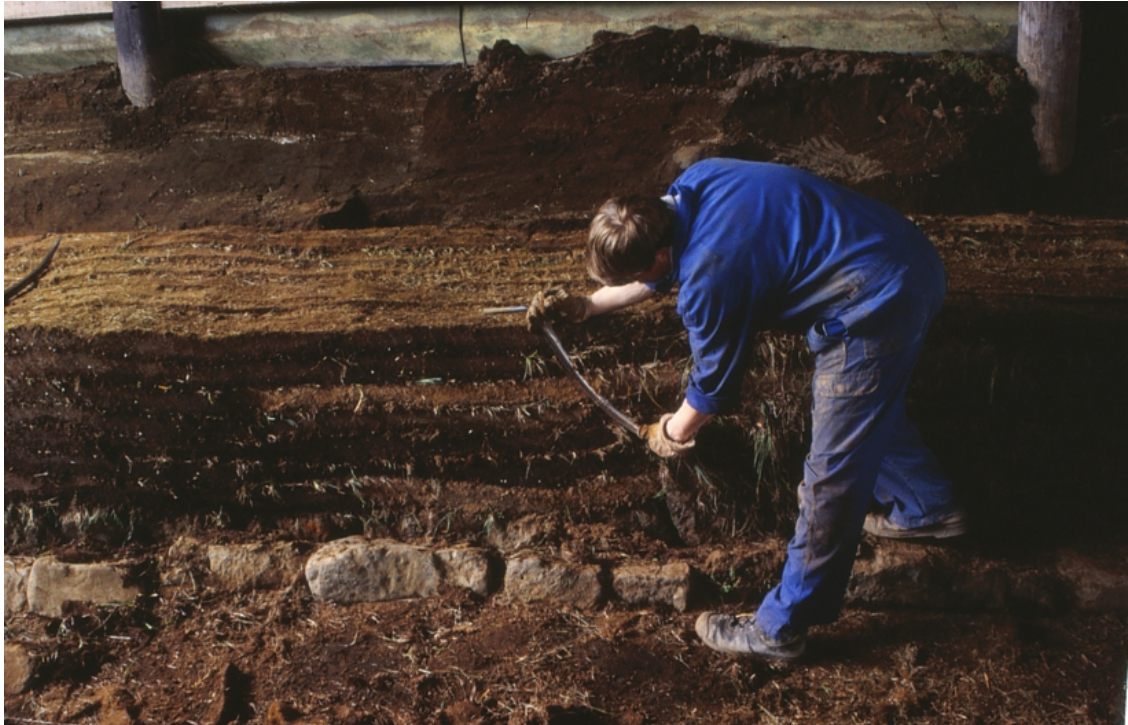
Mynd 37. Víglundur Kristjánsson hleðslumeistari sker strenginn til með torfljá sínum.
