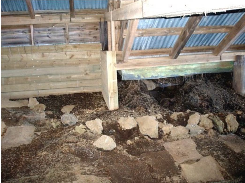
Mynd 43. Inni í stofunni er mikill leki og eyðilegging, þar sem viðgerðum var ekki lokið á skýlinu árið 1996.
