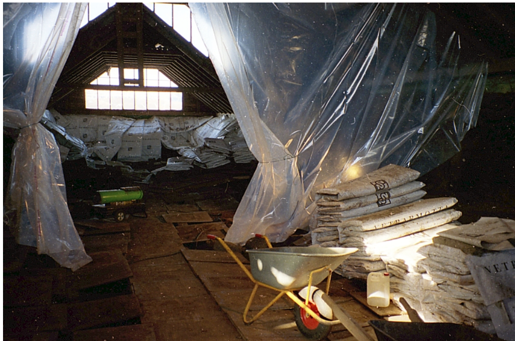
Mynd 31. Frá vinnu við viðgerðir í apríl 1994. Hitablásarar voru teknir í notkun til að þjóa frost úr jörðu.
