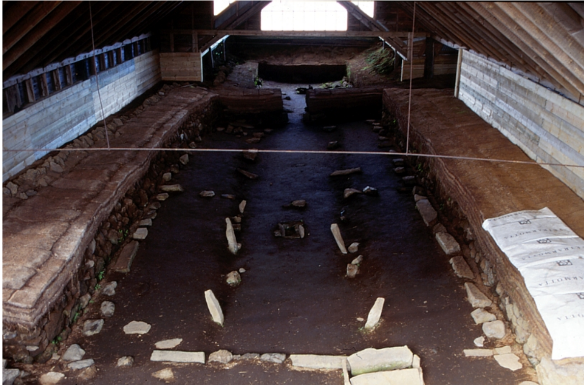
Mynd 38. Eftir viðgerðir. Árið er 1996, og strengur hefur verið hlaðinn ofan á veggina og þil, til varnar skriði og leka, smíðað inni í skýlinu.
